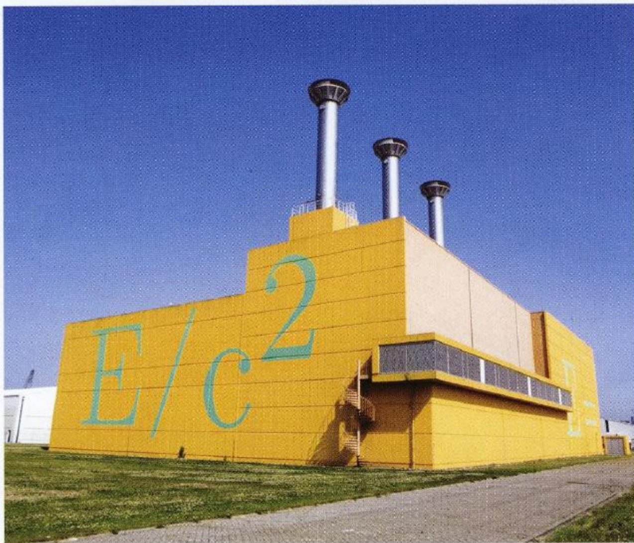
Bunker na 300 rokov: nad zemou, za 1,7 metra silným betónom, skladuje Holandsko svoj vysoko rádioaktívny nukleárny odpad.
